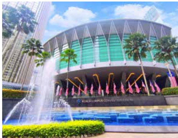
クアラルンプールコンベンションセンター
