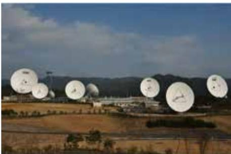
写真1 KDDIは、同社の山口衛星通信所にStarlink衛星回線のゲートウェイ局を設置してサービス開始に備えている。(出典:kddi.com)
