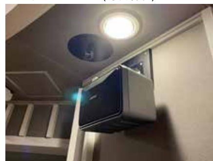
スタジオフロアのステージ (写真上) に設置されている、 ステージボックス (写真左下) とトークバックスピーカー (写真右下)
