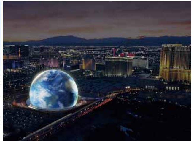
収容人員 17,500 人、9 層構造延べ床面積 87,5000 平方フィート 室内部 LED スクリーン解像度 19,000x13,500(屋外にも LED スクリーン設置) HoloPlot による 15,700 台の音響変換器による波面合成次世代音響
