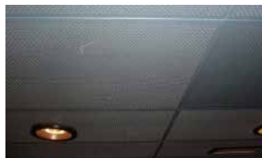
パネル継ぎ目が見える施工例
