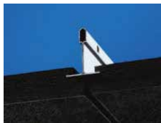
天井からの吊り下げ部分が隠されている施工例
