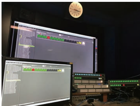
納入後の AXON エンジニアによるビルドアップ作業。
