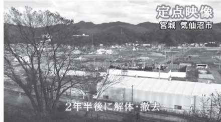
定点映像（宮城県気仙沼市鹿折地区）
