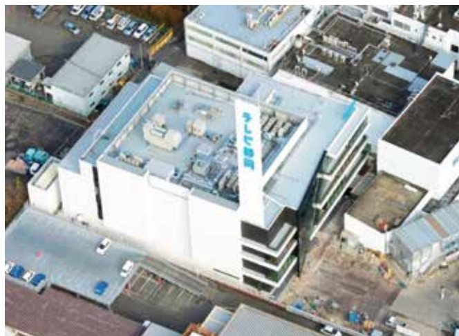
テレビ静岡新社屋全景（平成29年1月）
