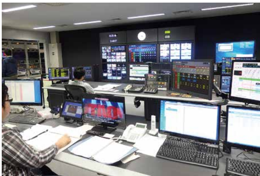
オレンジ色の3階マスター監視室のトビラと内部
