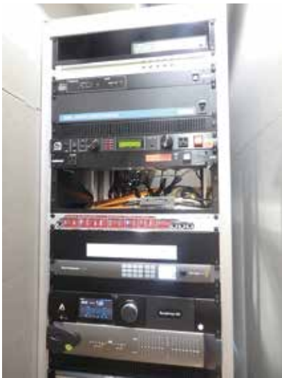
コンパクトに収納された機材ラック
