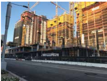
コンベンションセンターの周辺では、街の再開発が進んでおり、多くの高層ビルが建設ラッシュとなっている。
