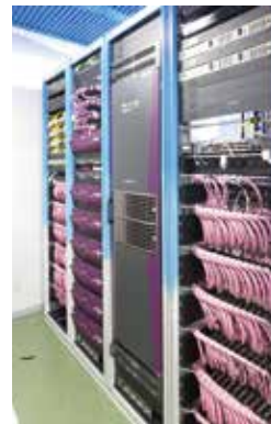
マシン室の大型アーカイブ設備とその内部、ラックにはガラスバレーのマシンが並び
