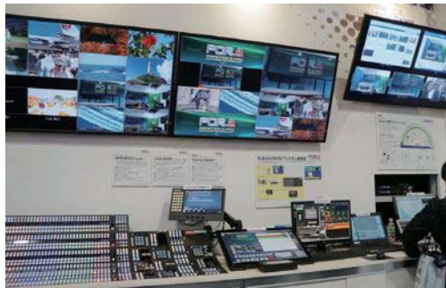
写 25: 主カススイッチャー HVS2000 を核にしたシステム構築
