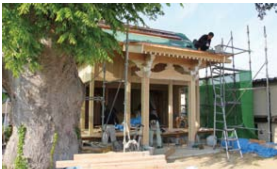
写真1 須賀川城の本丸跡・二階堂神社は桧造りで再建
