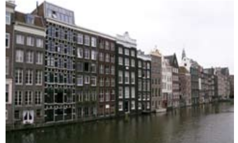
写 15. 前後左右に傾いているように見える運河沿いの建物もある
