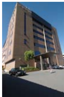
テナントとして入るビル
