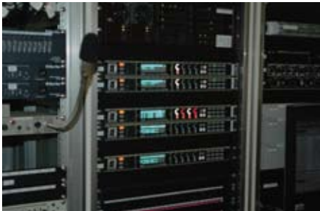
FS・コンバーター：中継回線FS・アップコンバート用として朋栄のFA-9100が並ぶ
